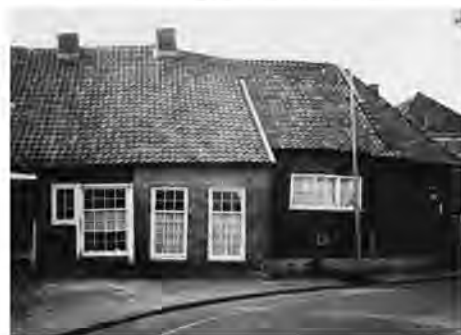
foto 1970 woonhuis van Jan Krabben in 1971 afgebroken t.b.v. de doorgang Rentenierstraat - Dijkstraat
