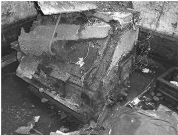
Wat overbleef van de oude (boven) en de nieuwe (rechts) verwarmingsketel. De ketels werden met cokes gestookt. In de onder water gelopen kelder ligt (onder) nog het stookgereedschap.
