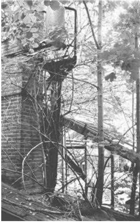
Achter de kas was een stookhuisje met gemetselde schoorsteen. De verwarmingsketels stonden in een kelder.
