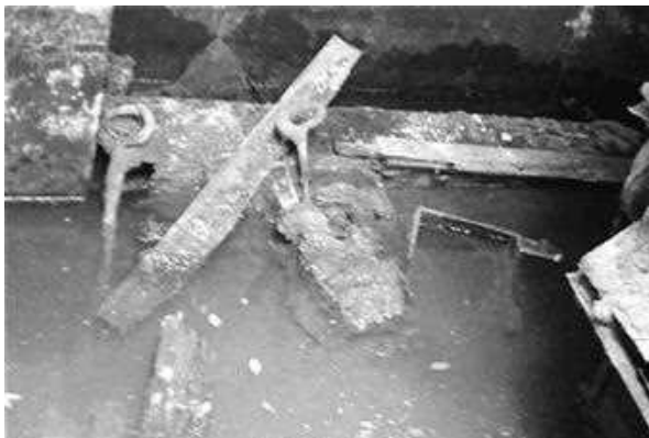
Wat overbleef van de oude (boven) en de nieuwe (rechts) verwarmingsketel. De ketels werden met cokes gestookt. In de onder water gelopen kelder ligt (onder) nog het stookgereedschap.
