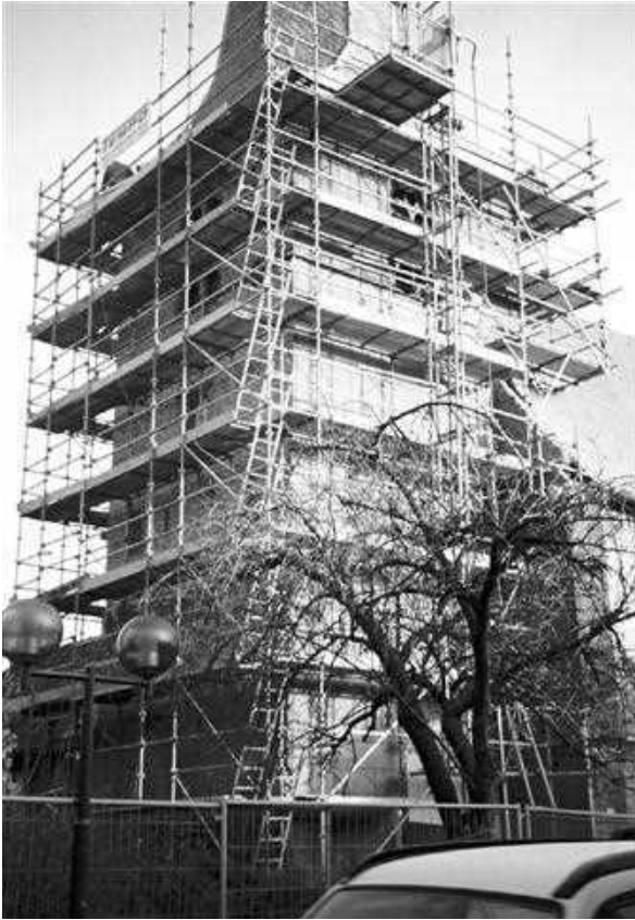
De toren wordt in de steigers gezet.
