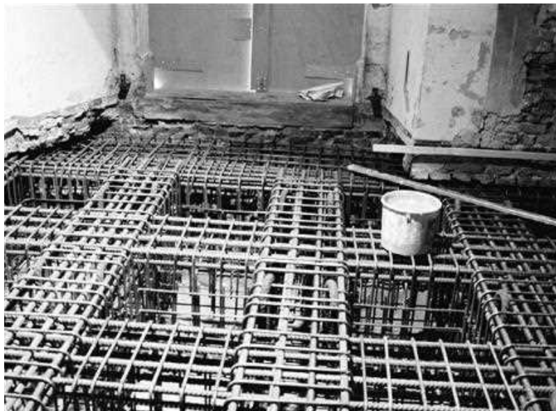
Een nieuwe stevige fundering wordt aangebracht. fotocollectie F. van Lochem
