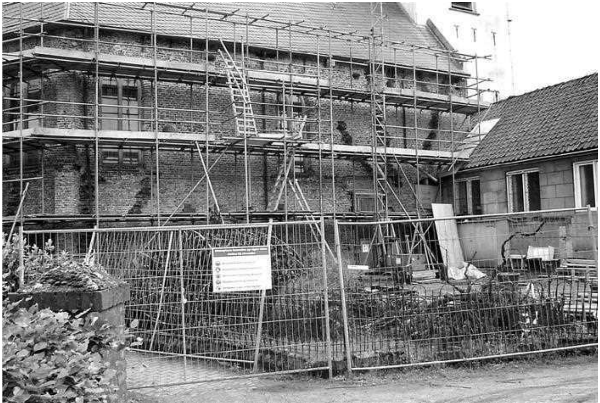
De noordmuur na afbraak stookhok en verwijdering oude pleisterlaag. fotocollectie F. van Lochem
