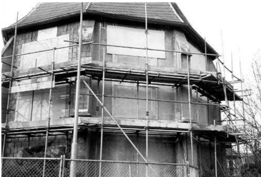
De ramen zijn uitgenomen voor het opnieuw verloden. fotocollectie F. van Lochem
