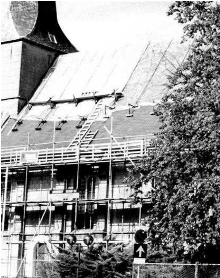
Het kerkdak wordt voorzien van nieuwe leien. fotocollectie F. van Lochem
