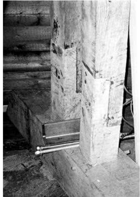
Gedeeltes van draagbalken worden vervangen.
