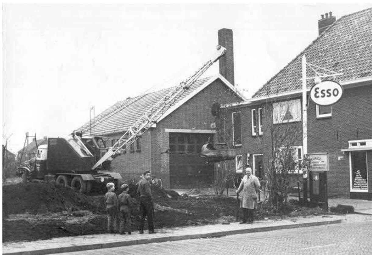
Verbouwing en uitbreiding van de garage in 1962; het grondwerk werd in die tijd door Dusseldorp nog met een dragline uitgevoerd. Op de voorgrond in werkjas Bertus Knippenborg. Fotocollectie: mevr. van Rooden.
