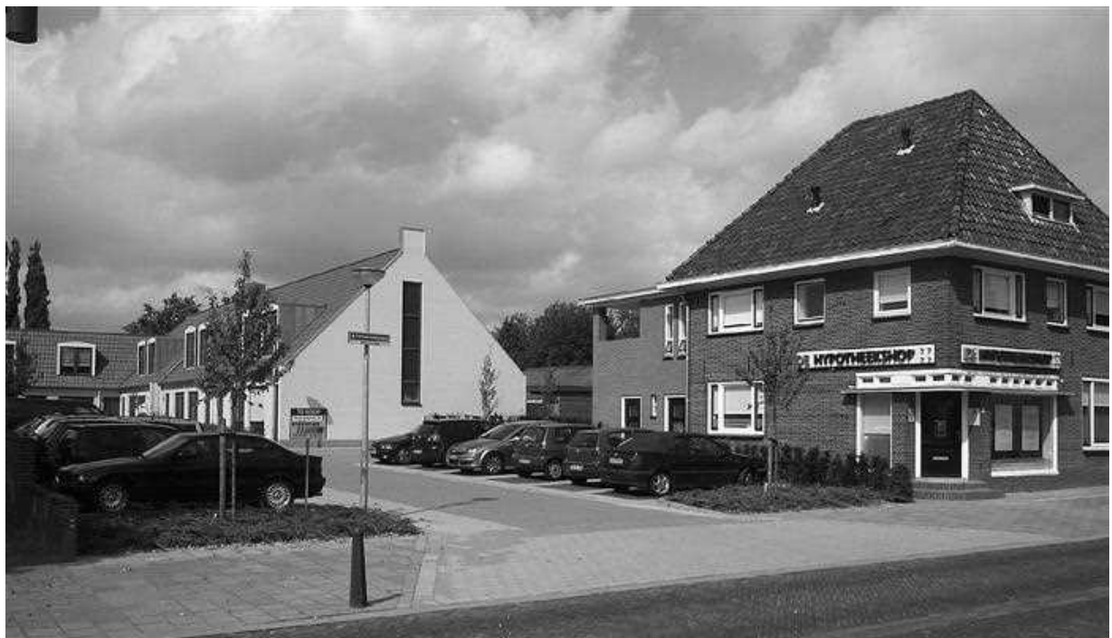
In 2005 is de garage gesloopt en zijn op het vrijkomende terrein kleine woningen gebouwd. Het vroegere woonhuis en winkel uit de jaren dertig werden in oude staat hersteld. Fotocollectie: Frits van Lochem
