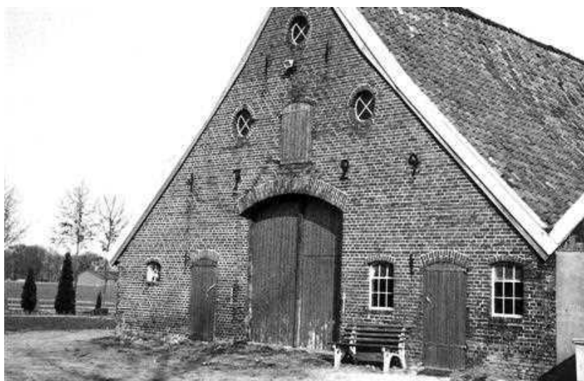
De boerderij Hunink-Orriëns aan de achterzijde. In de gevel muurankers met het jaartal 1729.
