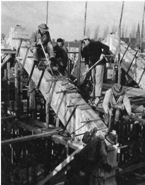
Het storten van de betonnen spanten van de werkplaatsvleugel. Het beton wordt met de kruitwagen aangevoerd en handmatig aangestampt in de houten bekisting. Moderne trilnaalden waren er nog niet.
