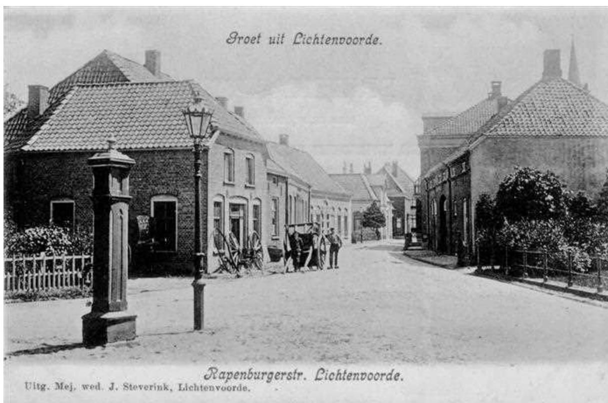
Zicht op de Rapenburgsestraat omstreeks 1905. Rechts het huis gebouwd door J.H. van Basten Batenburg, daarachter het pand op de plaats van het huis van de familie Ten Bosch.
