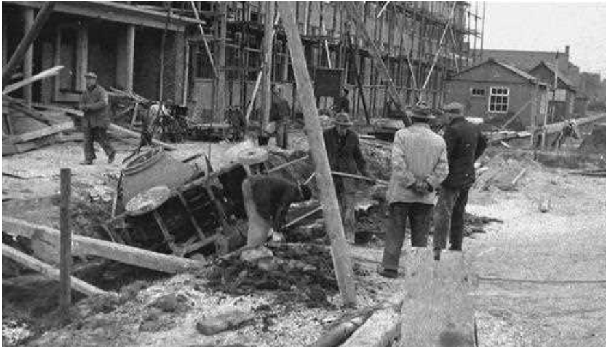
Overzichtsfoto van de bouw gezien, vanaf de Rode van Heeckerenstraat. Vandalen hebben de betonmolen omverge- duwd waardoor deze in de sloot is beland. Met deze ene molen is alle beton en metselspecie voor het gebouw gemaakt.
