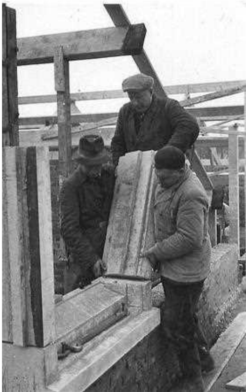
Montage van één van de vooraf gemaakte betonnen ramen.
