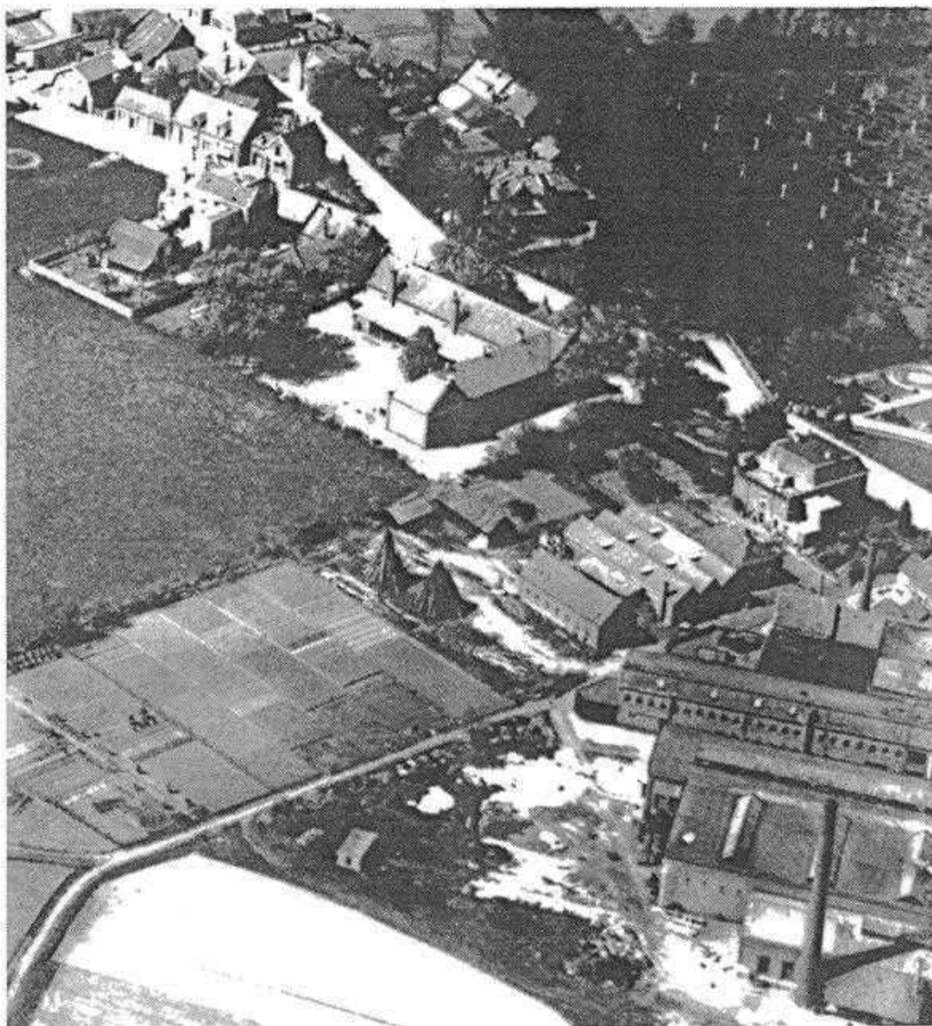
Hier een foto van een stukje Lichtenvoorde waarop we in het midden het fabrieksgebouw van de fa. Buijnink herkennen, terwijl we linksboven een gedeelte van de Dijkstraat zien en rechtsonder een gedeelte van de fabrieksgebouwen van de fa. Hulshof/Herwalt
