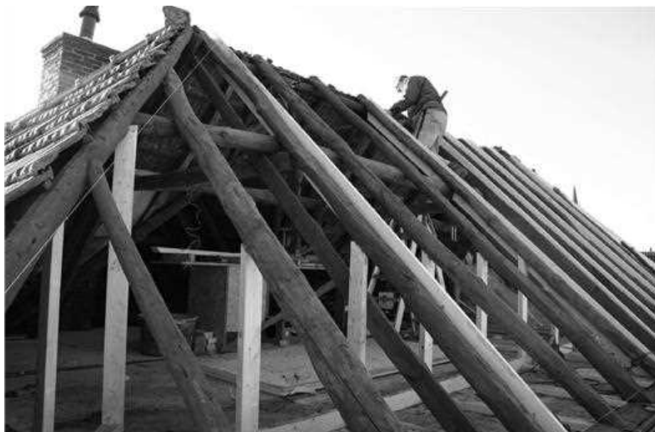
Restauratie van de dakconstructie; sporen worden opnieuw gesteld en uitgevuld. De schoorsteen is opnieuw gemetseld. Foto: Leslie Rietveld
