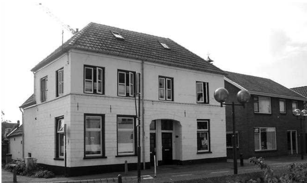
Het gerenoveerde pand anno 2007. Foto: Frits van Lochem
