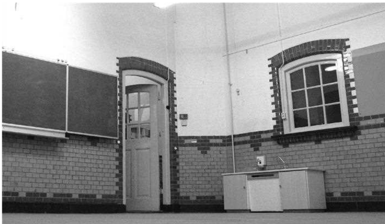
Interieur oude St. Jorisschool met de zeldzame geglazuurde bruine en gele stenen als lambrisering en een van de originele deuren met panelen.
