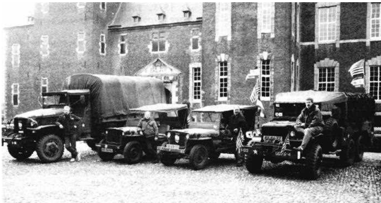
Op de foto zijn enkele types te zien : van links naar rechts een GMC 5-tons vrachtwagen, twee jeeps en een Dodge met achter een dubbele as.
