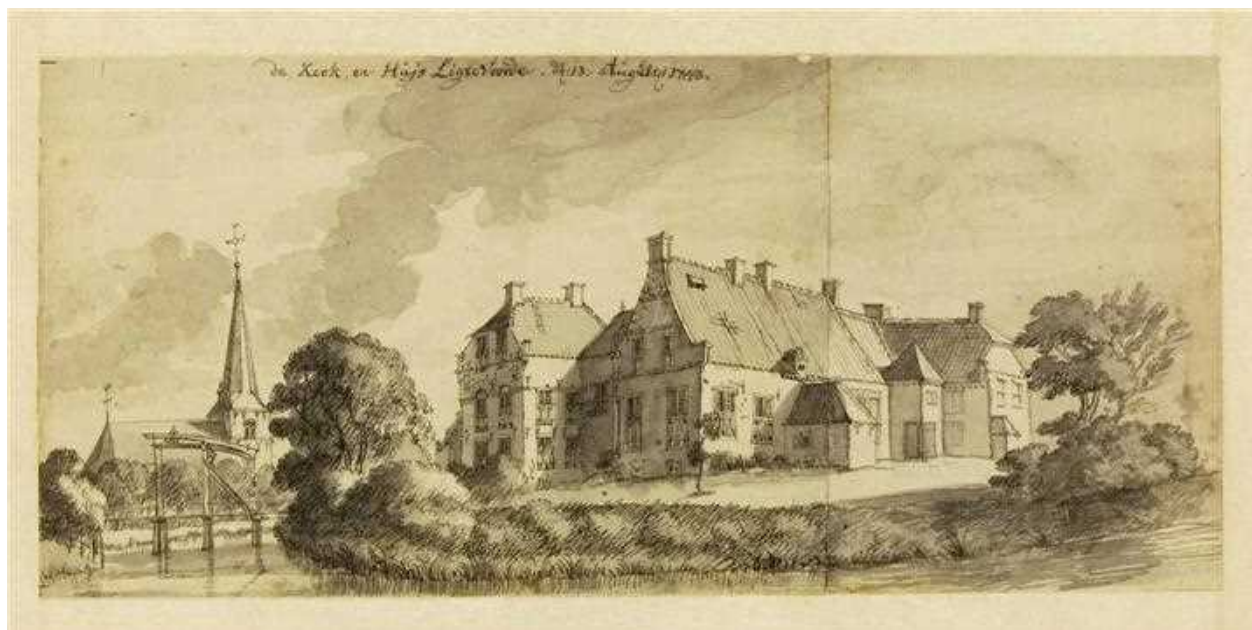
Gelders Archief te Arnhem. Kerk en huis te Lichtenvoerde. Tekening van Jan de Beijer, 1743. Het huis was omringd door grachten en was toegankelijk via een ophaalbrug
