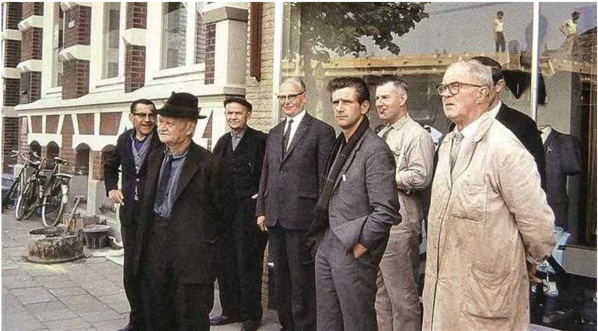
Enkele Lichtenvoordenaren kijken toe hoe de Nieuwe Leeuw wordt geplaatst in 1966.
