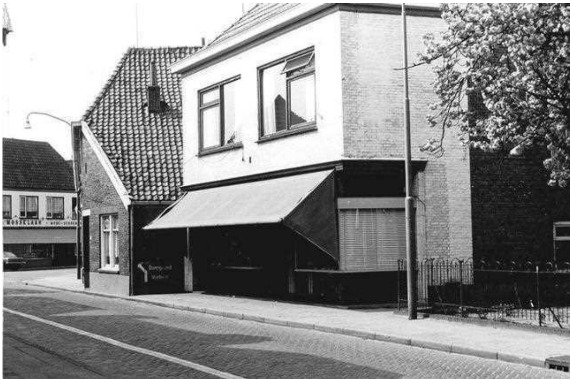
Rentenierstraat 5. Vanuit de andere kant gezien bakkerij-winkelwoonhuis Stottelaar. Dit pand had oorspronkelijk een Jugendstil-voorgevel met een klein torentje (zie de oude foto uit ca. 1930 van de kerk net daarnaast). Al in de jaren vijftig van de vorige eeuw is het pand gemoderniseerd en de oude Jugendstil-gevel gesloopt.
