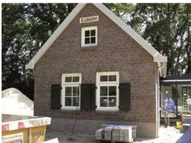
28 april 2013 voorgevel herbouwde 'Esboom' met gang tussen Esboom en de nieuwbouwwoning
