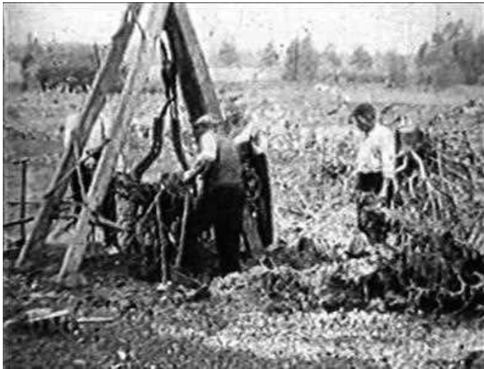
Stobben rooien was zwaar werk. De stobben worden met een verplaatsbare takel uit de grond getrokken en daarna in stukken gehakt. Foto uit dubbel 8 smalfilm van fotograaf Willem Wekking.
