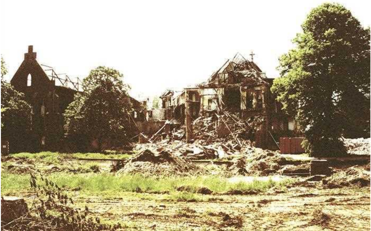
De sloop van het internaat te Harreveld in volle gang
