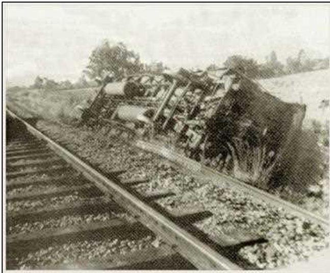
Bij Lievelede ontspoorde trein, veroorzaakt door sabotage aan de spoorlijn door het verzet. Fotograaf: onbekend
