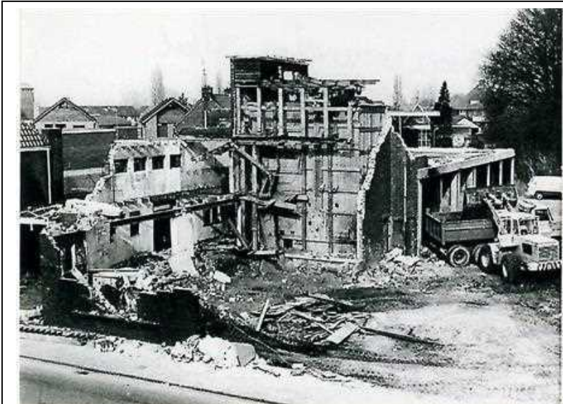
Foto 9 De sloop van de boerenbond en de voormalige woning van J.H. Ansink Aaltenseweg 19 en 21 in 1980. Collectie Benno van Lochem
