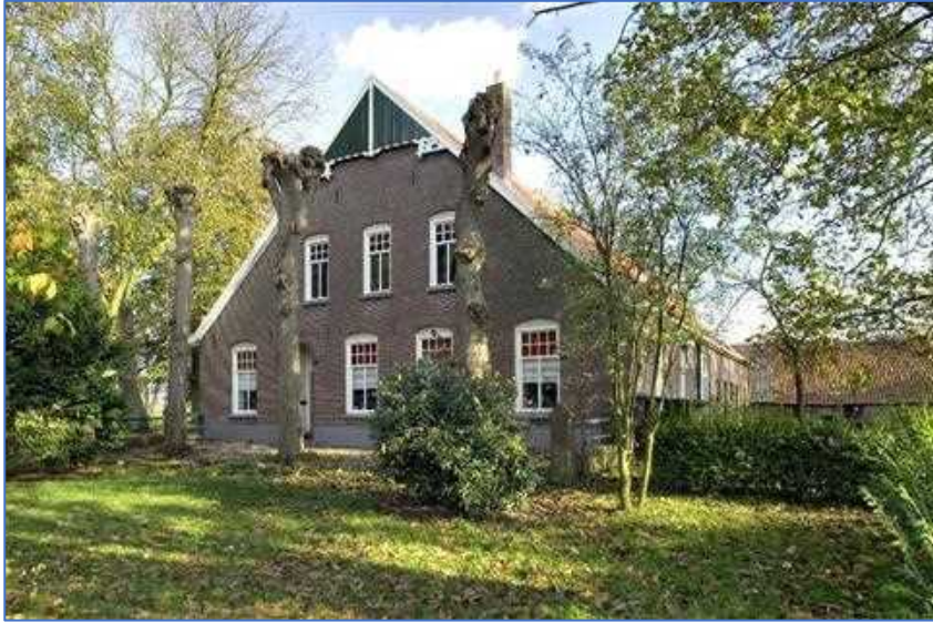
Afb.1 Voorgevel boerderij Pillen (foto Rijksdienst voor het Cultureel Erfgoed 2005).
