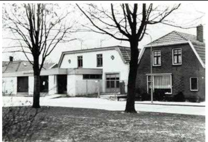
Foto 7 Van Reedestraat december 1989 net voor de afbraak. De dienstwoning die toen bewoond werd door de weduwe Harbers-Rouwhorst is behouden gebleven. Vervolgens zien we de uitbouw van de Welkoopwinkel met daarachter het pakhuis van de ABTB. Geheel rechts zien we nog net het dak van de woning J.B.A. Taken. Collectie Gerhard Eppingbroek
