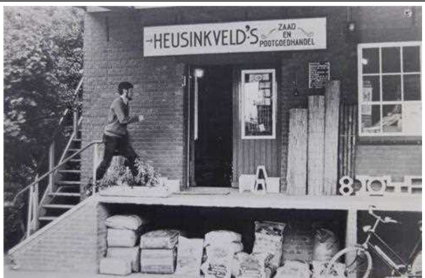
Foto 11 De zadenhandel Heusinkveld, aan de Patronaatsstraat op nr. 14. Het pakhuis is destijds afgebroken voor de bouw van de Franciscanerhof in 1983/84. Collectie beeldbank Saet en Cruyt Enkhuizen
