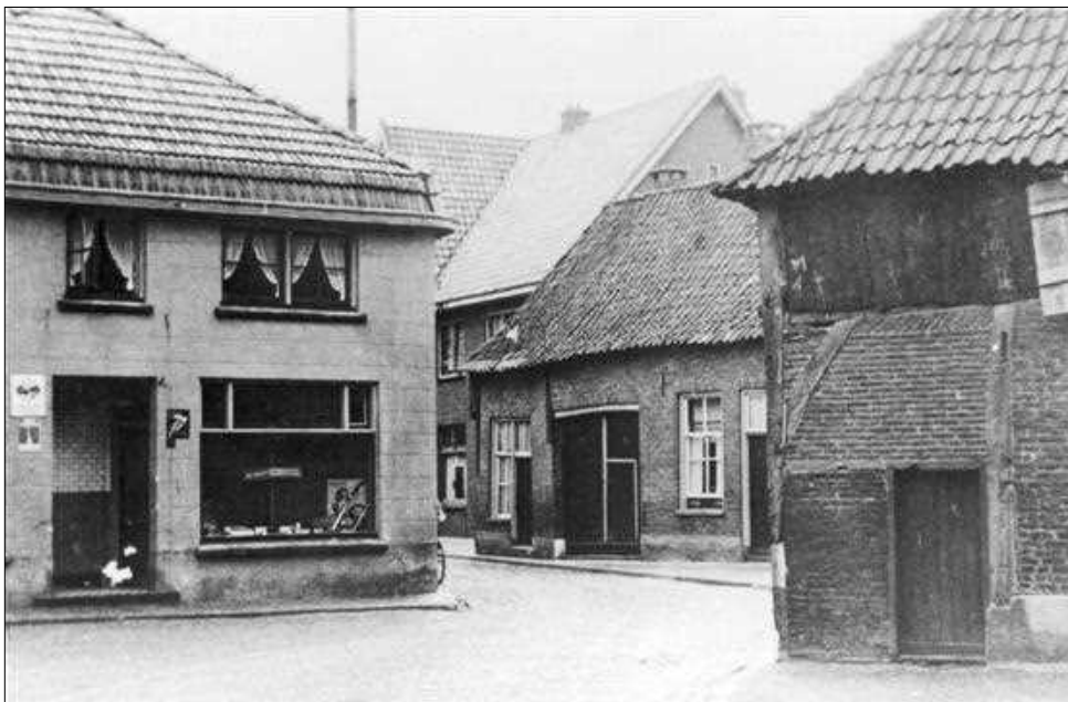
Vroeger keek je van hier rechts op het achterhuis van Krabben. Het huis van Tone Wolf is nu niet zichtbaar, wel de naastgelegen boerderijwoning van Stammers, die in 1952 werd gesloopt. Dit huis stond ver naar voren en de Rentenierstraat was ter plaatse erg smal. Er kon maar net een vrachtauto of bus door. De oude panden van Krabben, Wolf en Stammers dateren vermoedelijk van eind 18de of begin 19de eeuw. Nauwkeurige jaartallen zijn er niet van bekend. In het pand links was destijds loodgieters- en installatiebedrijf Ter Bille gevestigd.
