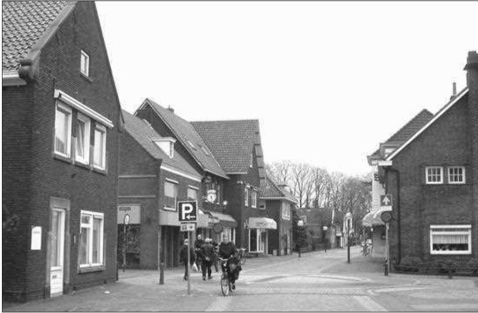
Links eerst het pand van Sensire, dan de toegang tot de Krabbenplas en vervolgens de panden van Dusseldorp, Ter Bille, Knufing en Haverkort. Rechts het dubbel woonhuis, gemeentelijk monument vanwege de stijlverwantschap met de zogenaamde Late Amsterdamse school, bouwjaar 1933 met daarnaast nog een beetje zichtbaar restaurant De Kiezel van Wopereis.
