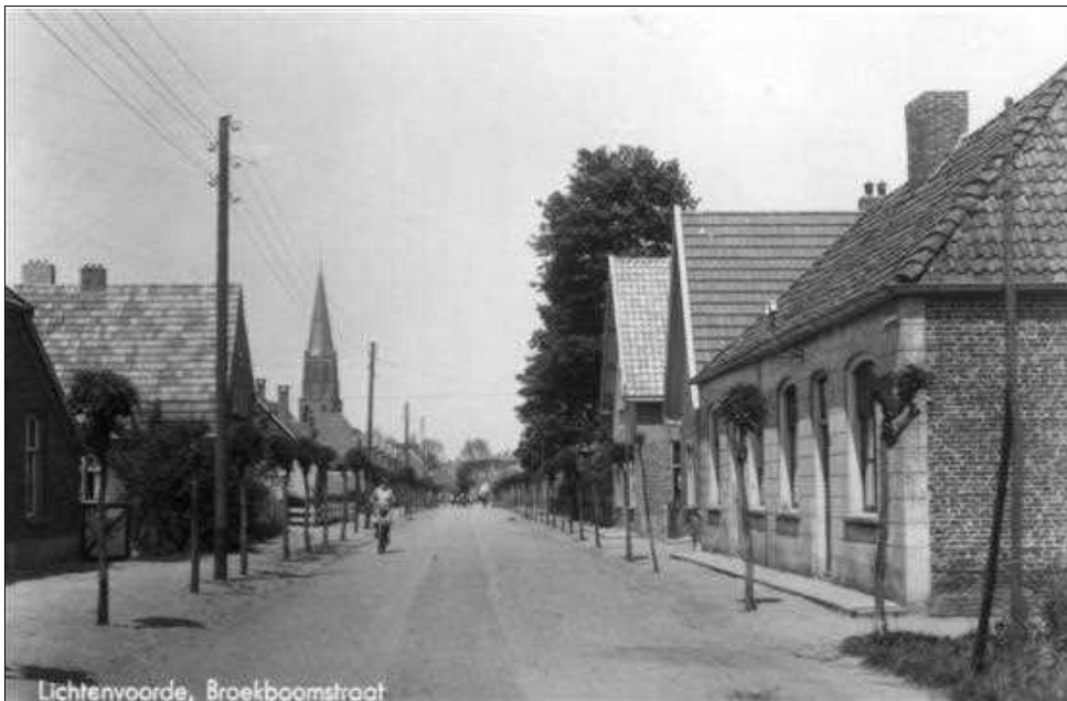
Het dubbele woonhuis rechts is bewoond door Wolterink en Lansink en is gebouwd eind 19de eeuw. Bekend is dat het huis gebouwd is van stenen die afkomstig zijn van de afbraak van het Huys Tongerlo, circa 1890.
