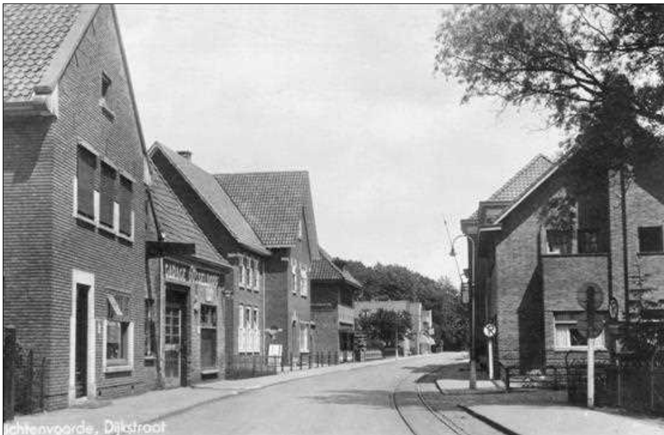
Dit is de Dijkstraat rond 1946 met veel panden uit de periode 1930 en 1940. Het woonhuis links is van Hulshof en gebouwd in 1936, dan de oude garage van Dusseldorp (bouwjaar niet bekend). Naderhand hebben hier achtereenvolgens Paashuis en Cuppers hun garagebedrijven opgestart en daarna waren er nog jaren groentehal Meinen en stomerijwinkel Boekelder gevestigd tot het pand in 1981 werd gesloopt voor de toegang tot de Krabbenplas. Dan was er nog een open perceel grond, waar later Dusseldorp Rijwielhandel verrees, vervolgens de Raiffeisenbank met daaraan vast de directiewoning, bouwjaar 1939/1940. In de woning woonde destijds directeur Hulshof. Vervolgens de winkel met woning van Reukers (of Ruikers volgens het geboorteregister), bouwjaar 1933. De overige panden links zijn niet meer zichtbaar. Rechts het dubbele woonhuis uit 1933, in 1946 bewoond door Meerdink en Wegman. Het hoge pand daarnaast is van de weduwe Stoer en vermoedelijk rond 1880 gebouwd.
