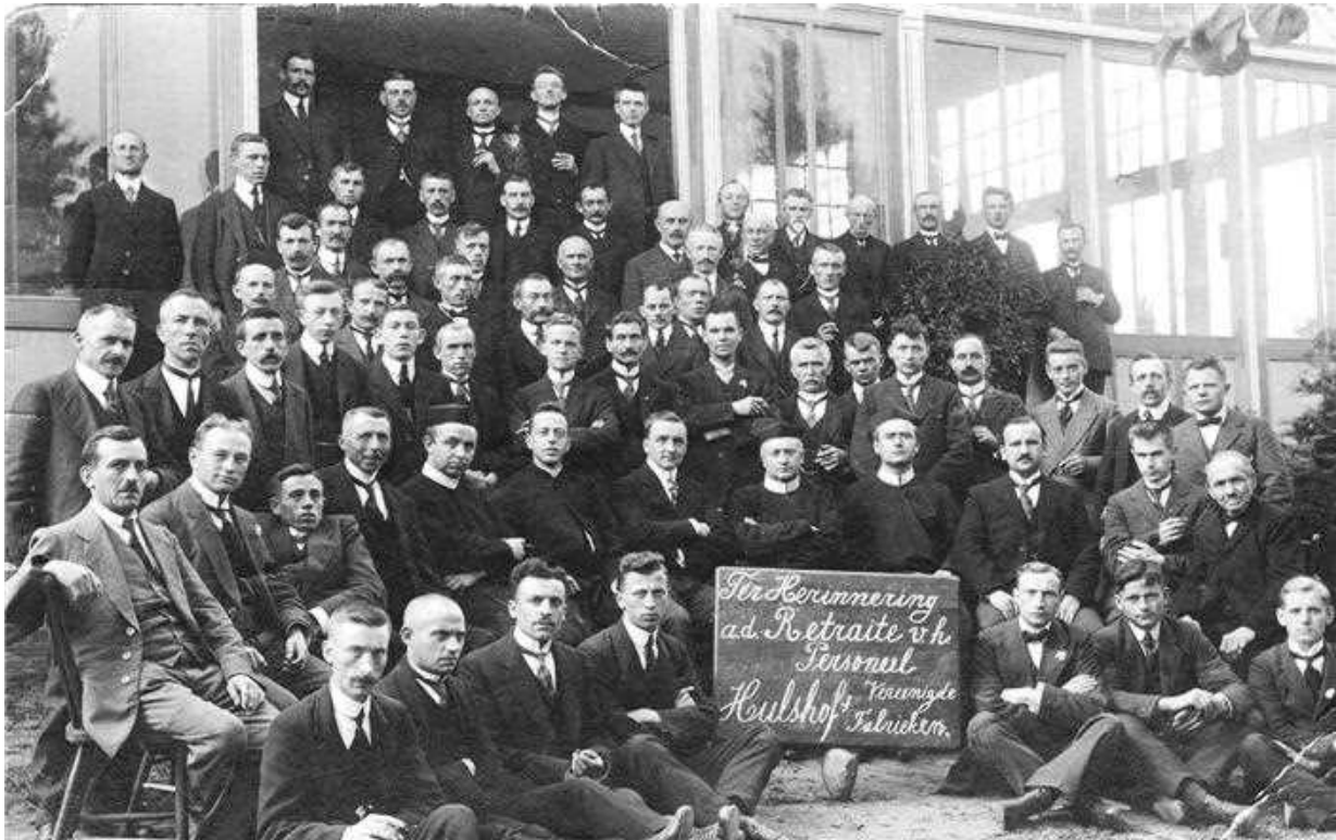
Groepsfoto van het personeel van de Verenigde Leer- en Schoenfabriek Hulshof bij gelegenheid van een retraite in 1919 te Amersfoort. Op de eerste rij links vooraan Willem Schutten op vierentwintigjarige leeftijd. Fotocollectie: G. Eppingbroek/vereniging voor Oudheidkunde.
