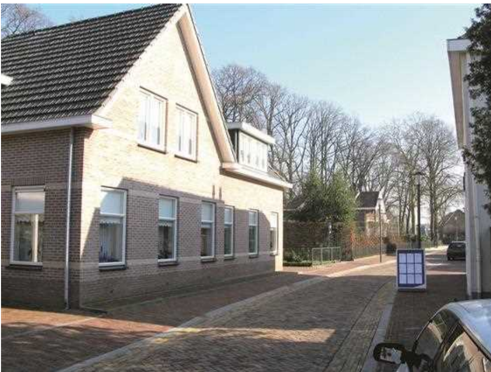
Het oude pand is gesloopt en als een soort make-over qua vormgeving vervangen door een nieuw maar veel groter pand, nu als dubbel woonhuis.
