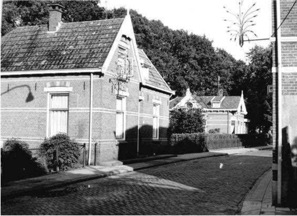
Het laatste deel van de Rentenierstraat.
