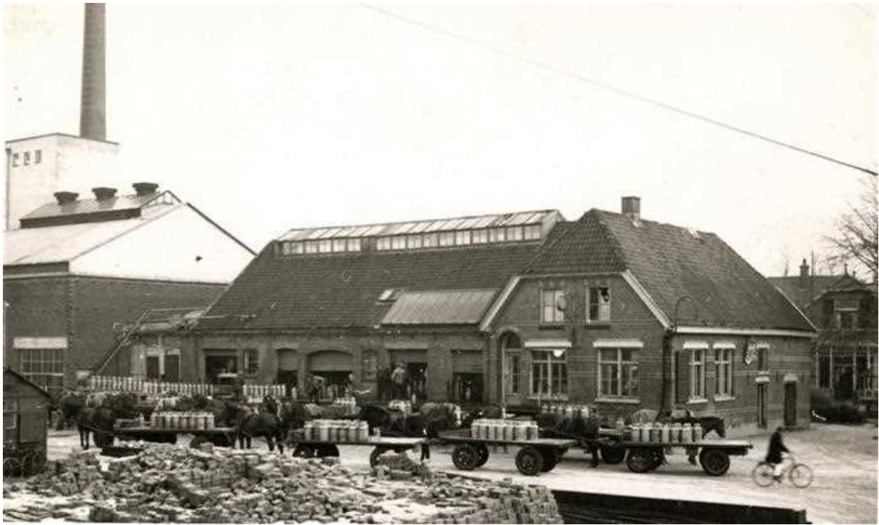
ca. 1935. De Coöperatieve Stoomzuivelfabriek ald Zieuwentseweg in Lichtenvoorde. Geheel rechts is nog juist een deel van de directiewoning te zien. De melkwagens waren al voorzien van rubberbanden, waardoor de zolders van de wagens lager kwamen te liggen. Dat was handig bij het opladen van de volle melkbussen.
