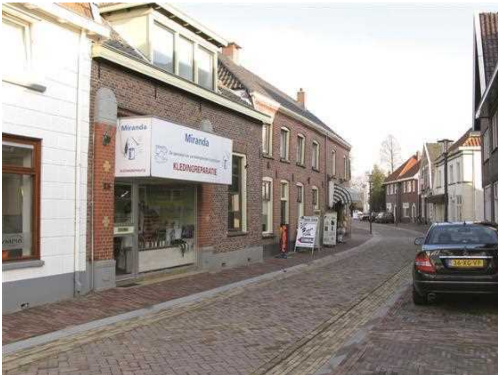
De zaak op nr.23 is al weer gewijzigd. Nu zit daar Hans Hissink met een winkel in nieuw en occasions witgoed. Nr. 25 is een gemeentelijk monument en is door eigenaar M. Broshuis gerestaureerd. Hij exploiteert hier een schoenmakerij annex winkel in aanverwante artikelen. Vanwege de karakteristieke sobere bouwstijl met toch fraaie detailleringen en maatverhoudingen is dit pand uit ca.1910 op de gemeentelijke monumentenlijst geplaatst.
