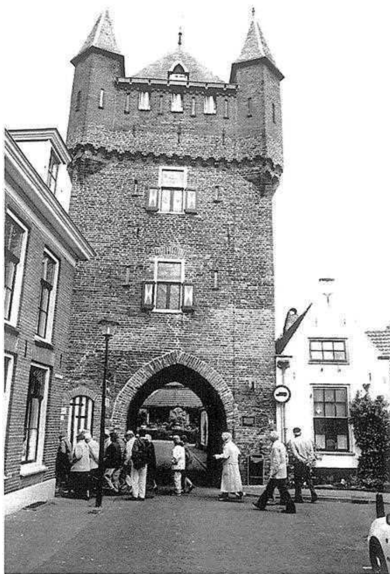
De Dijkpoort te Hattem (Collectie G.J.A. Eppingbroek, Winterswijk)
