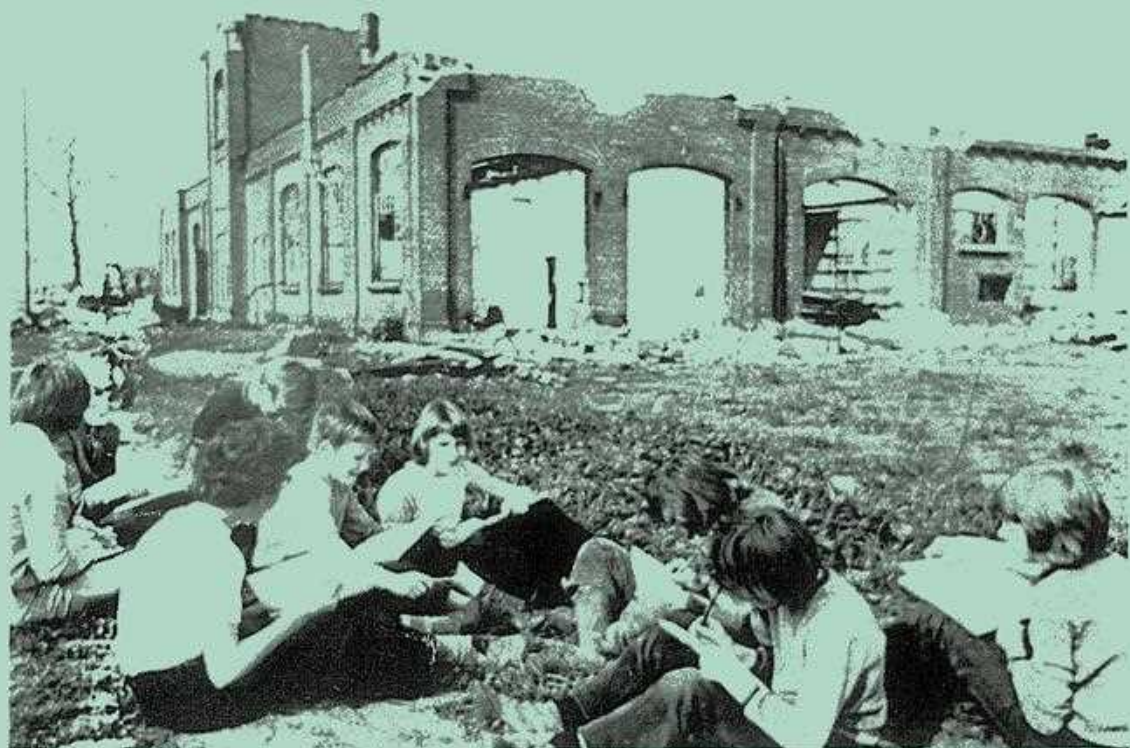
Afbraak voormalige tramremise
