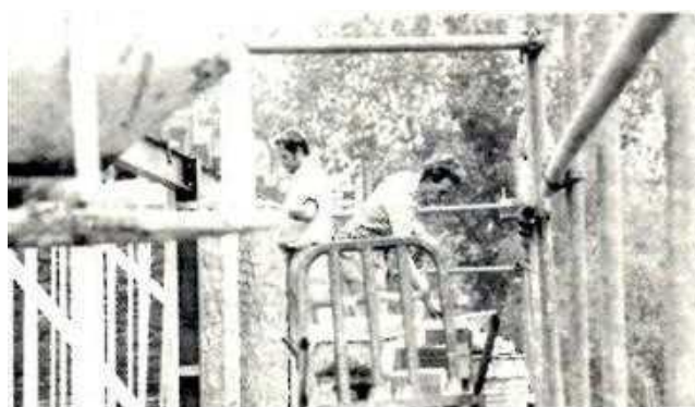
Metselaars Hemmie Buil en Leo Hogenelst druk met de bouw van de sporthal. Fotocollectie ELNA
