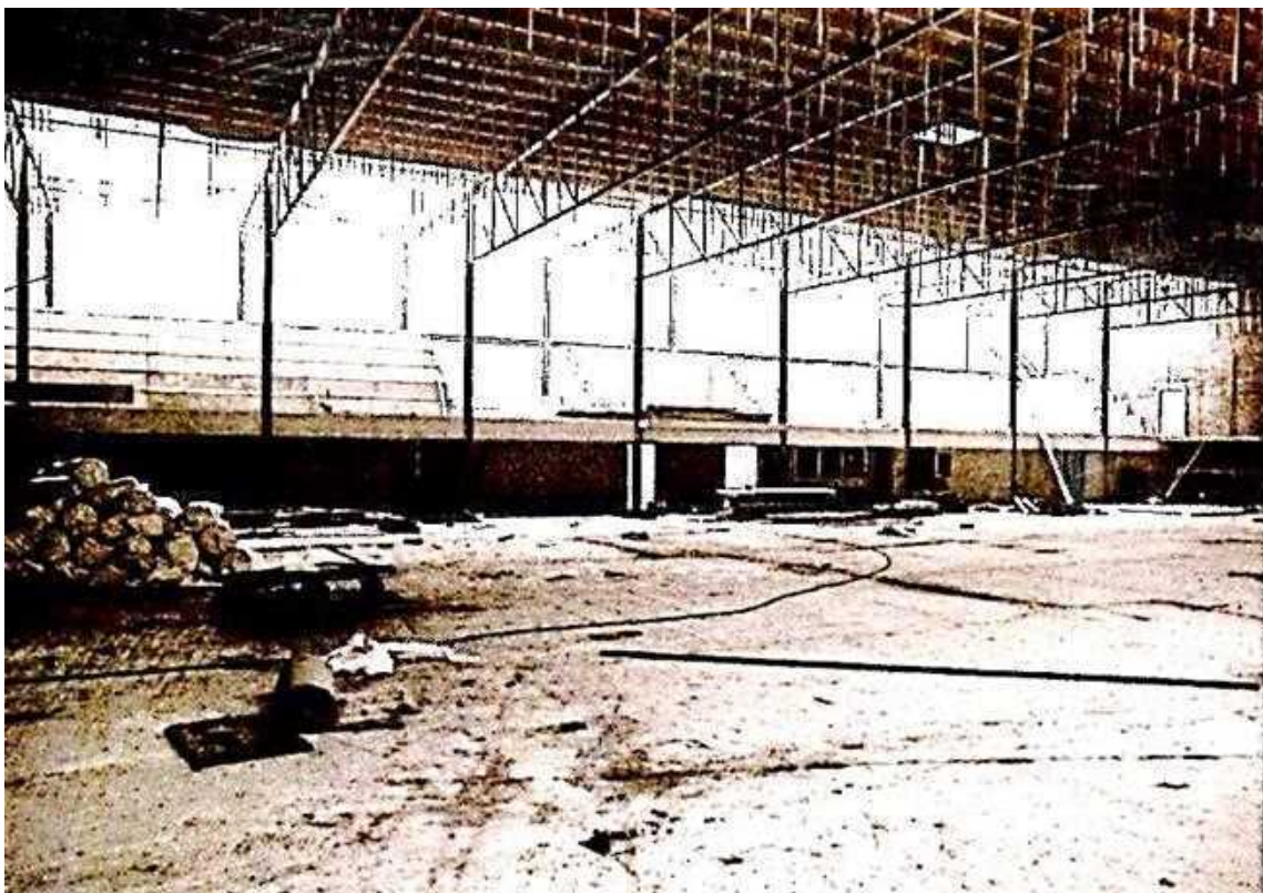
De vorderingen van aannemer Tenten en Installateur Somsen uit Eibergen zijn dusdanig dat het dak erop kan. Fotocollectie gemeentearchief.
