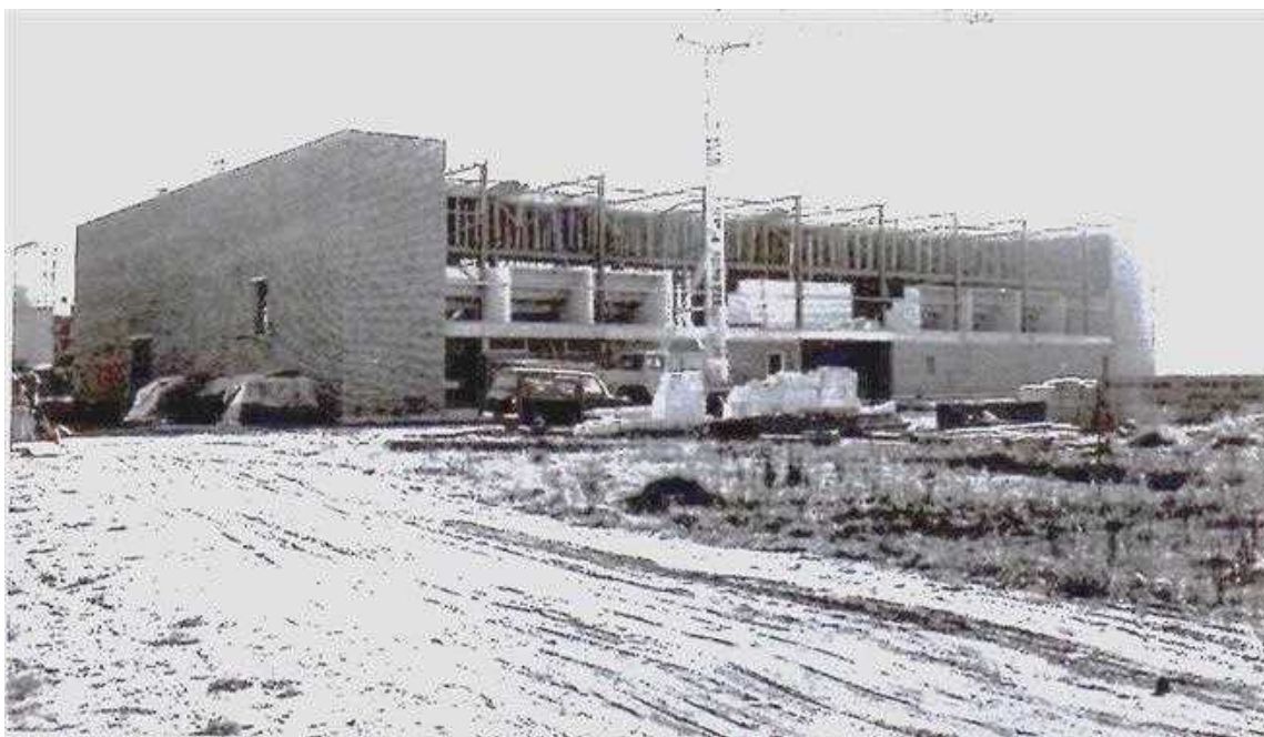
De werkzaamheden aan het plafond zijn in volle gang terwijl de tribune nog geen dak heeft. Fotocollectie gemeentearchief.
