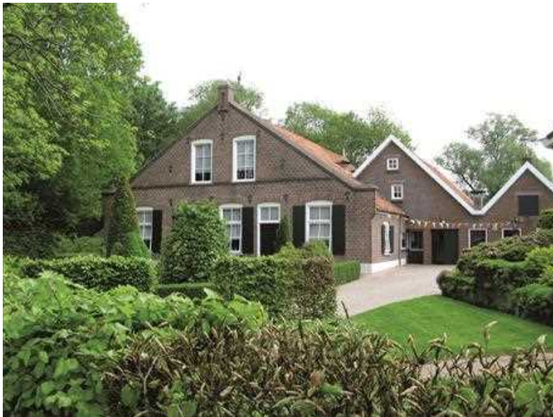
2013 Boerderij Wassink; voorgevels
