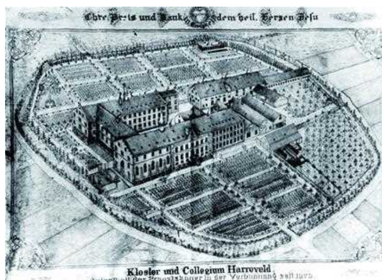
Het oude gebouw, geflankeerd door de eerste twee aanbouwsels. Fotocollectie G.J.A. Eppingbroek.
